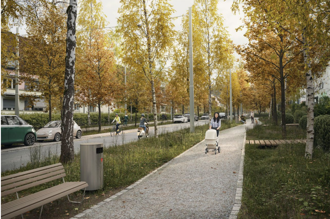
Abbildung 31: Visualisierung der Umgestaltung der Guggachstrasse nach dem Schwammstadt-Prinzip: Die versickerungsfähigen Flächen tragen nicht nur zur Wasserspeicherung, sondern infolge erhöhter akustischer Absorption an den weniger schallharten Oberflächen auch zu einer verbesserten akustischen Qualität bei.
