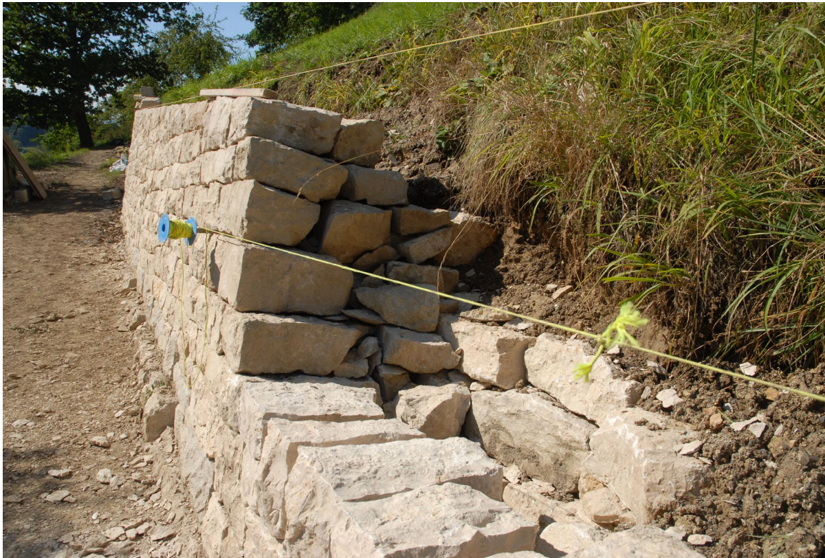
Trockenmauer während der Sanierung mit Blick auf die Hintermauerung. © creaNatira GmbH
