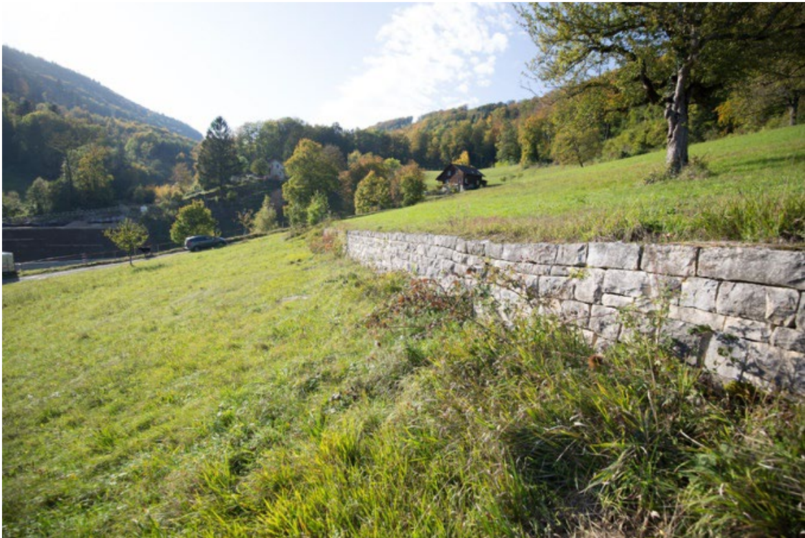
Frisch sanierte Trockenmauer mit einem breiten Altgrassaum entlang Mauerfuss und -krone.
