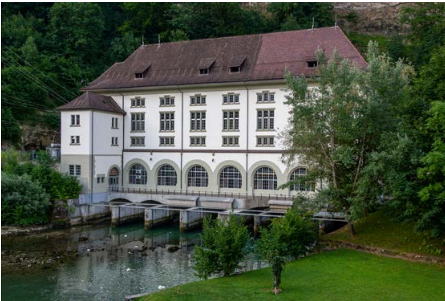
Centrale énergétique de la Maigrauge, ancienne usine hydraulique et barrage, Fribourg
