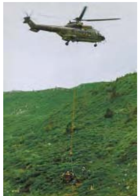
Massnahme zum Schutz empfindlicher Flachmoore während der Bauphase: Auf dem Schiessplatz Glaubenberg (Kt. Luzern und Obwalden) wurden 1996/97 automatische Trefferanzeigeanlagen eingebaut. In Gebiete, in welche ein Transport mit Fahrzeugen nur durch empfindliche Flachmoore möglich gewesen wäre, wurde das Baumaterial mit Helikoptern transportiert. In landschaftlich empfindlichen Gebieten ist der Einsatz von Helikoptern unter Umständen auch als Ersatz für Strassenerschliessungen gerechtfertigt.
