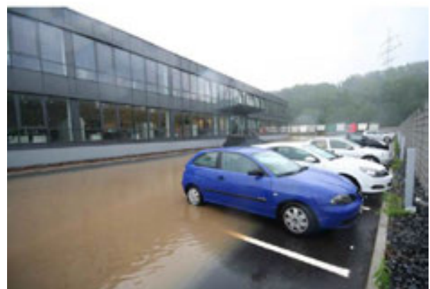
Abb. 53: Temporärer Einstau eines Parkplatzes (Quelle: Ramboll Studio Dreiseitl)
