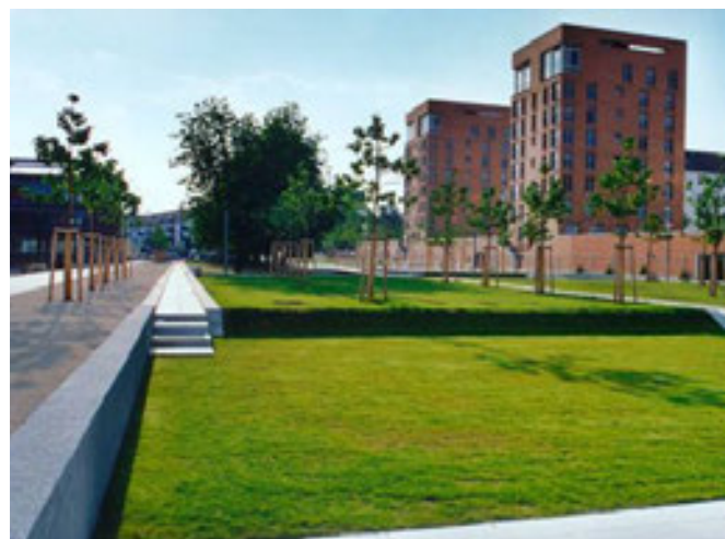
Abb.12 ...Mulden-Rigolensysteme (hier die Hainretention) weiterleiten.
