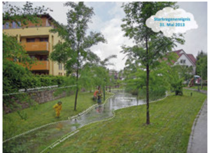
Abb.6 Aue: Ableitung, Rückhaltung und Reinigung des Regenwassers
