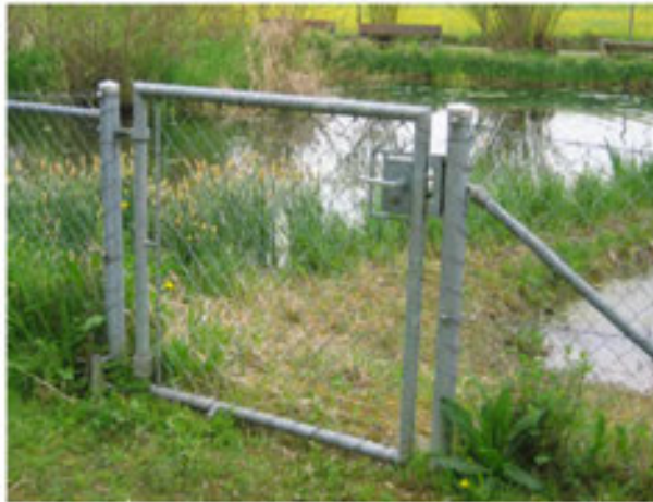
Abb. 16: Gesicherter Eingang zum Teich (Quelle: BFU)
