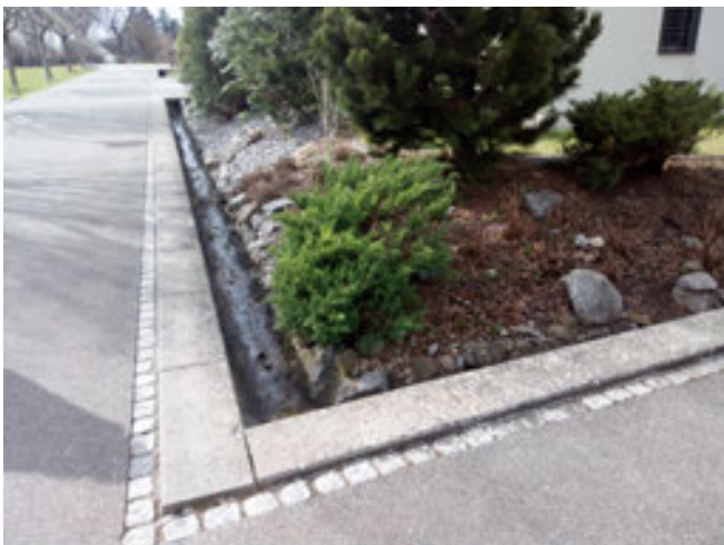
Abb.11 Wasserrinnen bringen das anfallende Dachwasser...
