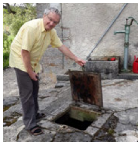
Abb. 41: übliche Zisterne für die Speicherung von Dachwasser, hier im Jura (Quelle: ILF)
