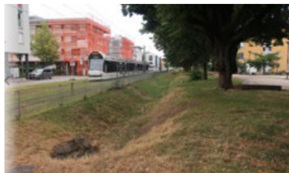
Abb. 59: Mulden-Rigolensystem neben Geleisen, als Teil der Infrastruktur (Quelle: ILF)
