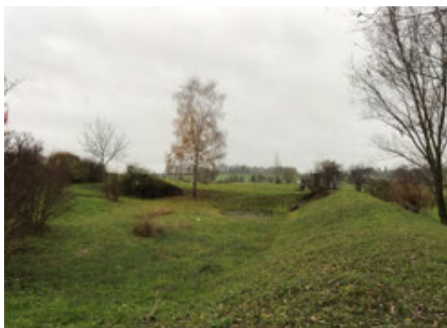
Abb. 45: Rückhaltebecken Wigarten in Wetzikon: hier wird Hang- und Regenwasser aus dem Quartier zurückgehalten und gedrosselt in den Vorfluter abgeleitet (Quelle: ILF).
