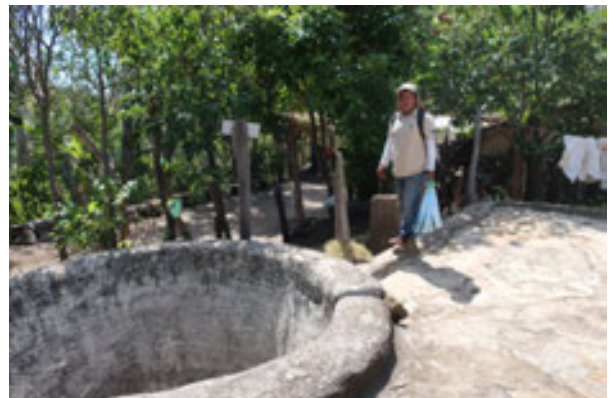
Abb. 44: Wasserspeicher angehängt an eine Dachfläche in Nicaragua (Quelle: M. Schirmer)
