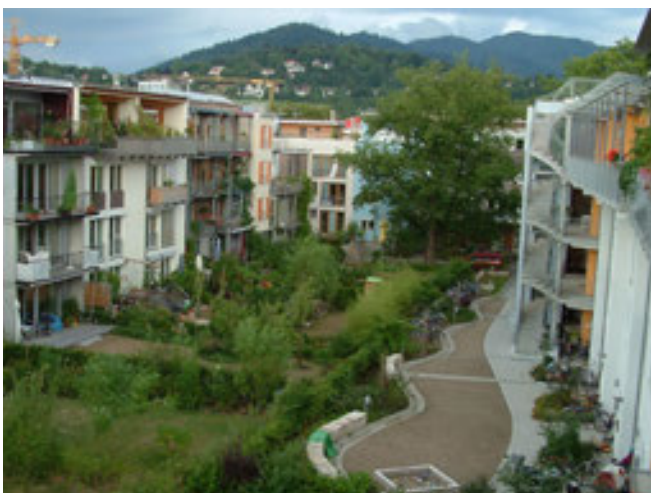
Abb.5 Geschwungene Regenwasserrinnen leiten das Dachwasser...
