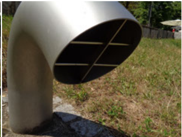
Abb. 77: Drosselung durch Sperre in mehreren Überlauf-Segmenten (Quelle: ILF)
