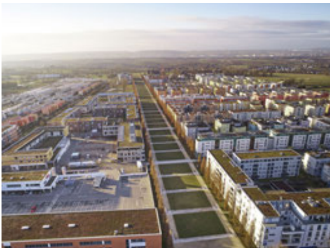
Abb.5 Unzählige Dachflächen liefern einen beträchtlichen Teil...
