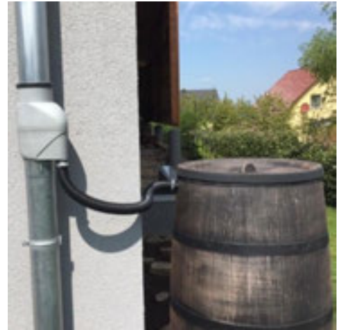
Abb. 42a+b Wasserfass/Regentonne (offen/geschlossen): wegen der Mückenthematik empfiehlt sich ein geschlossenes Fass (Quellen: naijaloaded.com / petes-prepper-guide.com)
