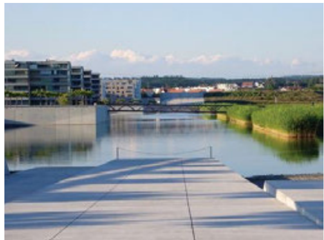
Abb.6 Beton und Schilf ziehen klare Grenzen zum Wasser.
