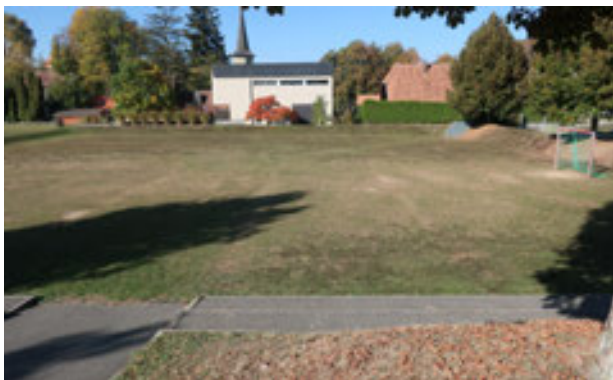
Abb. 50: Sportplatz in Fribourg als temporärer Retentionsraum. Seitlich sind Böschungen als Dämme gestaltet, im Hintergrund ist der Ablauf mit Rechen ersichtlich, der im Überschwemmungsfall Geschwemmsel zurückhält (Quelle: ILF)
