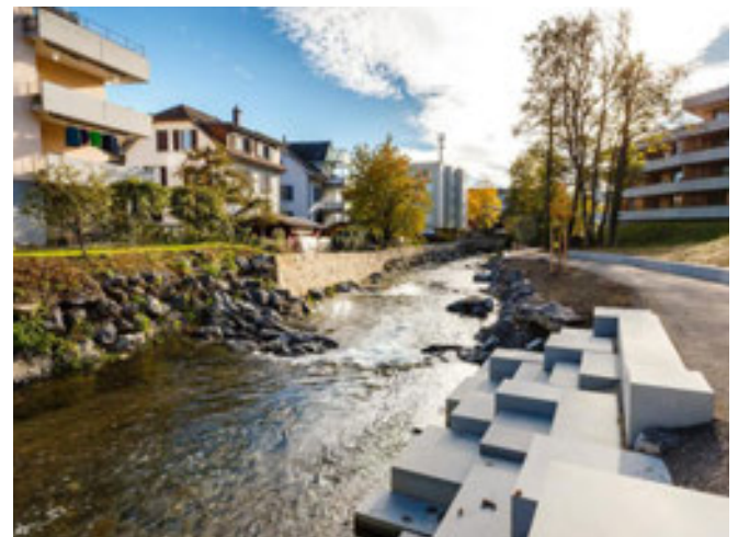
Abb.9 Markant und urban ausgestaltete Zugänge zum Aabach
