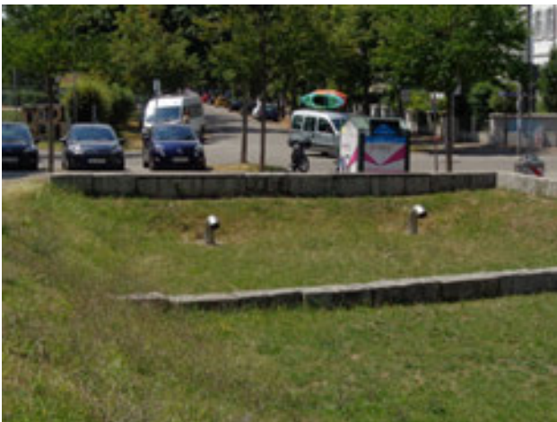
Abb. 78a+b: Drosselung mit Überlaufrohren, Freiburg (Quelle: ILF)
