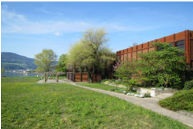
Abb. 85: HSR Gebäude 4 im Bestand (Quelle: ILF)
