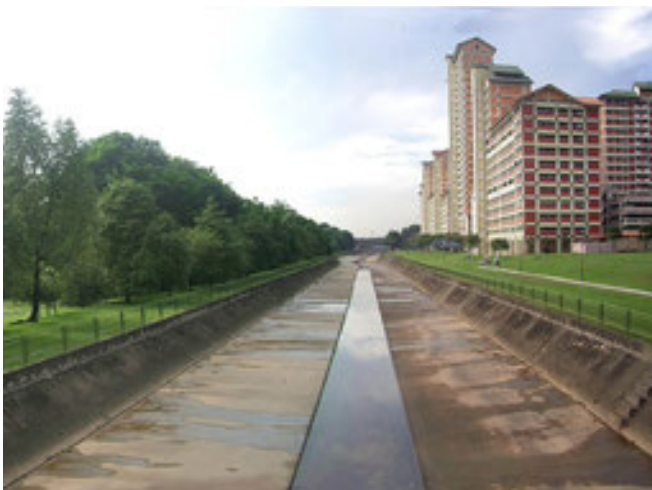
Abb.5 Früher: Ein Betonkanal mit kaum Fassungsvermögen
