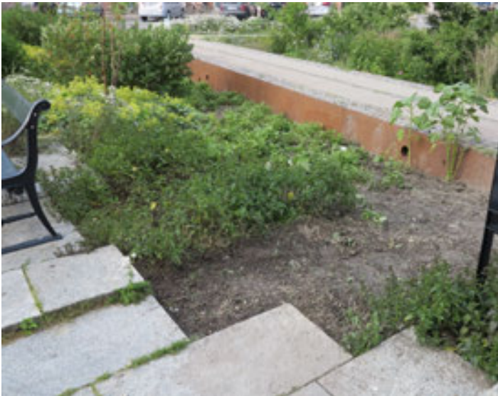
Abb. 74: Drosselung durch Ablaufrohr in Mauer (Staudamm) (Quelle: ILF)
