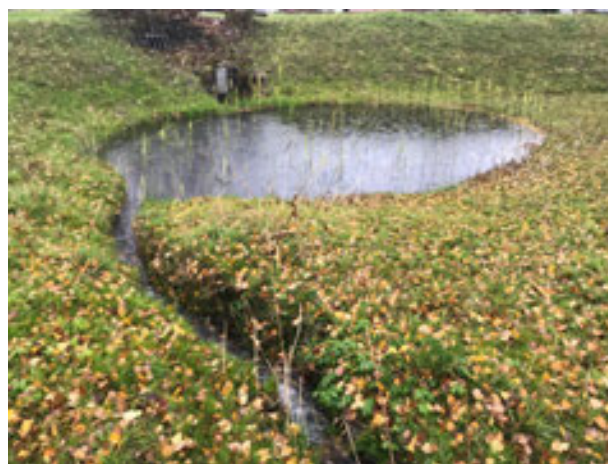
Abb. 46: Rückhaltebecken Wygarten in Wetzikon: kleine permanente Wasserfläche, im Hintergrund Überlauf mit technischem Drosselorgan (Quelle: ILF).
