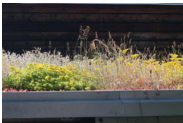
Abb. 62: Gründach mit Substrat (Quelle: ILF)
