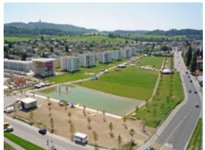
Abb.3 Aufnahme während dem Bauprozess des Parks
