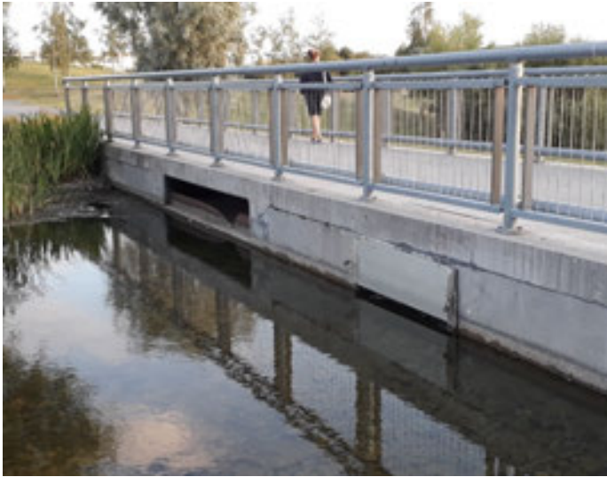
Abb. 76: Drosselung durch Staumauer mit Ablauf, gesteuert durch Tauchwand oder Schieber (Quelle: ILF)
