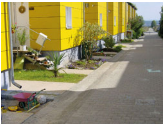
Abb.8 Ein Netzwerk aus offenen Rinnen verteilt das Dachwasser...
