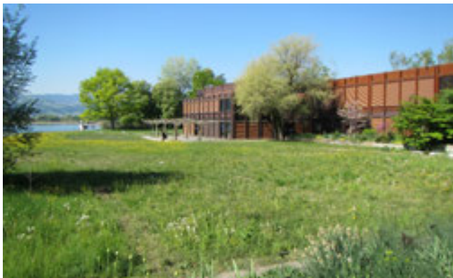
Abb. 87: Die extensive Wiese mit dem Schacht in der Mitte im Bestand (Quelle: ILF)
