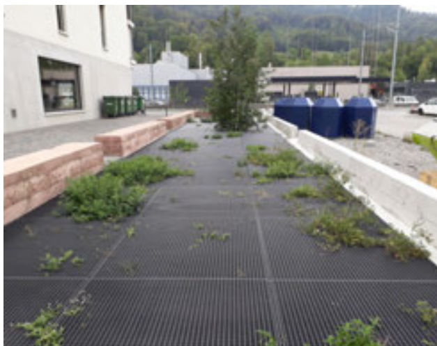
Abb. 1: Manegg, Stadt Zürich: Versickerungsbecken, überdeckt mit Gitterrost – es fehlt der Raum für mehr Synergien (Quelle: ILF).
