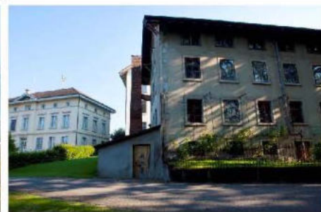
Historische Industriebauten von Meisterschwanden
